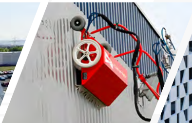
Fachadas y cubiertas de edificaciones industriales
